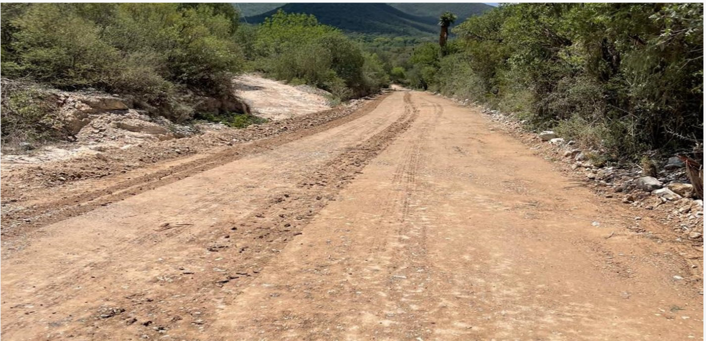
PAVIMENTACIÓN CON CARPETA ASFÁLTICA 1KM CARRETERA A EJIDO SAN LUCAS
