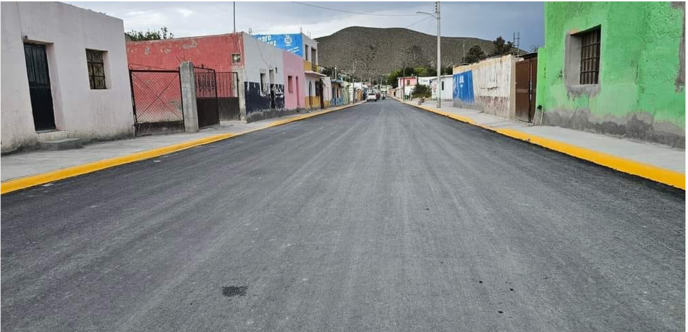
PAVIMENTACIÓN CON CARPETA ASFÁLTICA CALLE CUAUHTEMOC (2 DA ETAPA) GALEANA
